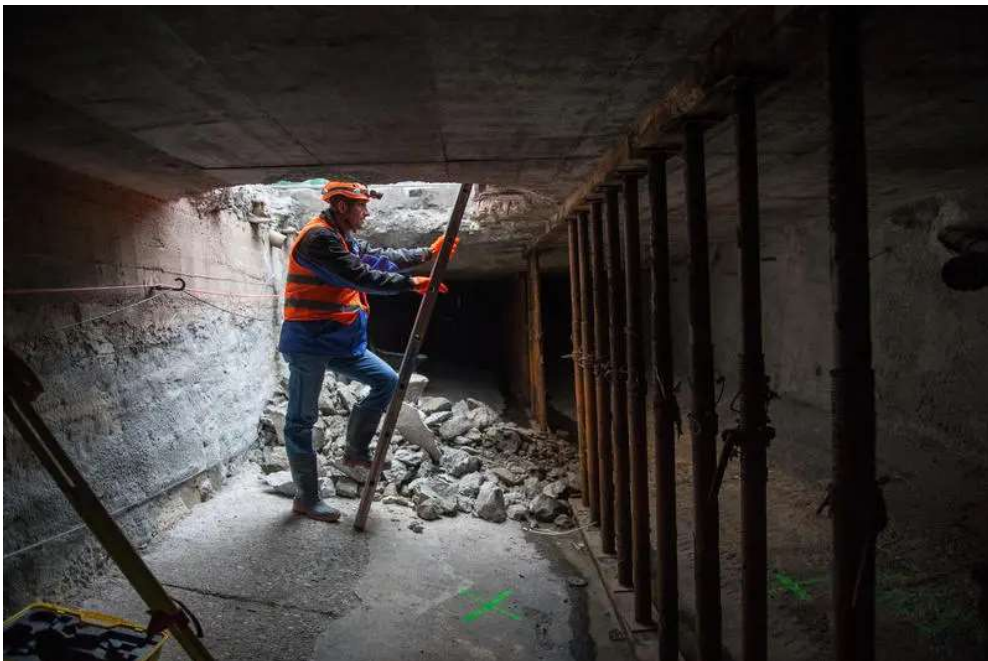
Urs Widmer, Leiter Abwasserwirtschaft bei der Real, auf dem Weg in den Krienbachkanal. (Bild: Dominik Wunderli (Luzern, 14. Dezember 2016))
